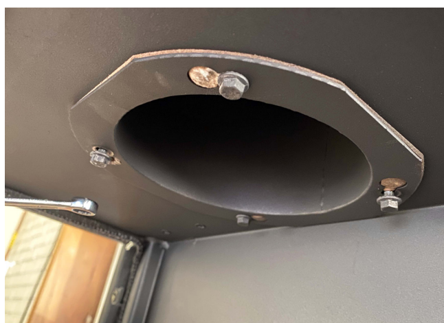
1. Desserrez deux des vis en diagonale.
