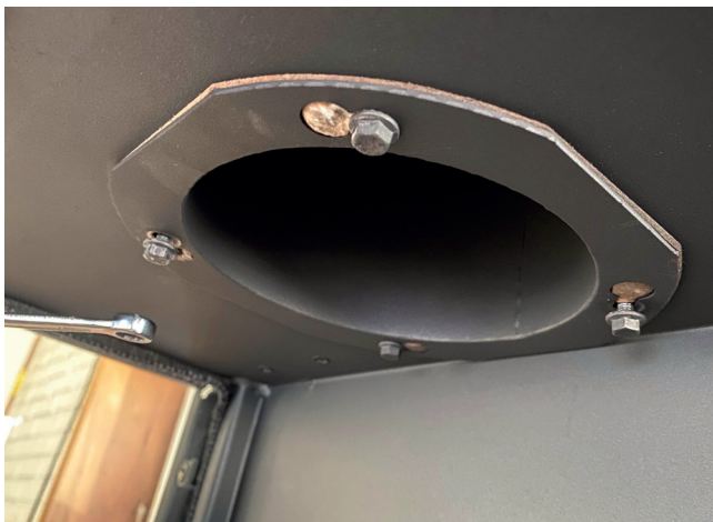
1. Desserrez deux des boulons en diagonale.
