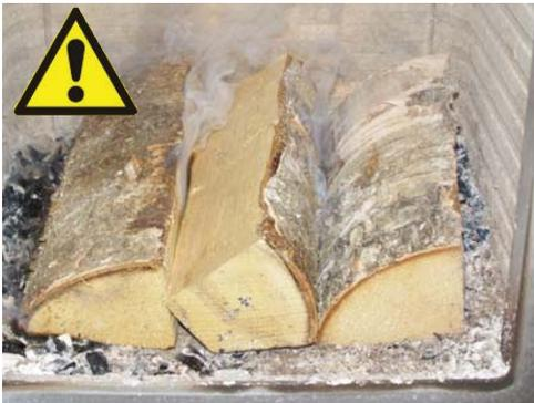
Hier wurde Brennholz zu einer zu kleinen Glutschicht hinzugefügt, die Luftzufuhr ist nicht ausreichend — es entsteht Rauch.
